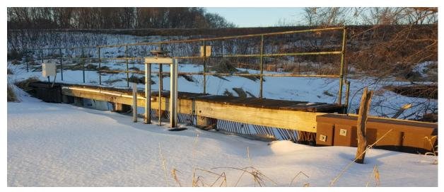
FIGURE 11 FERRIC CHLORIDE WEIR AND FISH BARRIER
