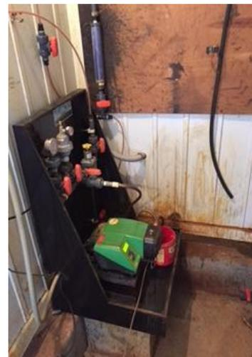
FIGURE 7 FERRIC CHLORIDE PUMP
